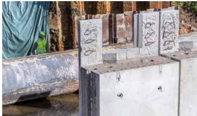
Unterbau: Aufstellen und Verspannen der Widerlager und Flügeltwände
