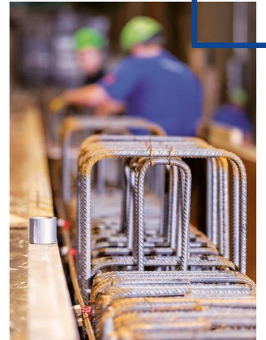
Bei den Anschlusspunkten an die Fertigteile und der Betonage ist besondere Präzision gefragt, damit die Anschlussbewehrung zentimetergenau positioniert werden kann
