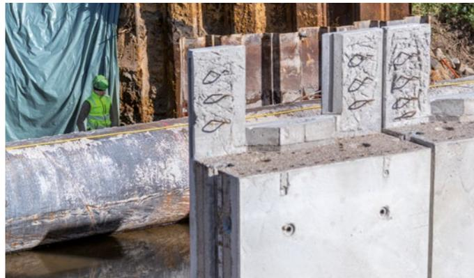
Unterbau: Aufstellen und Verspannen der Widerlager und Flügelswände
